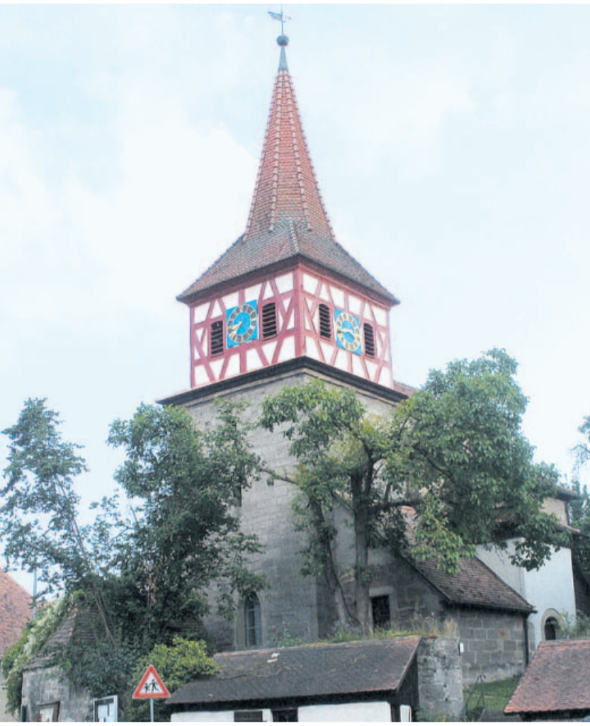
Frisch saniert ist der Turm der Egenhäuser Allerheiligenkirche, die vor 950 Jahren von Bischof Gundekar geweiht wurde. Foto: Göller
